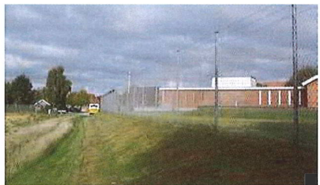
Foto fra den sydligste spids af Aulum Vandværks indhegning med kig mod Vestergade og vejadgangen.
